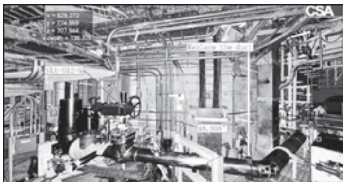
Presné meranie a kótovanie, inteligentné štítky prepojené na ďalšiu dokumentáciu, poznámky, tvorba 3D CAD modelov priamo v laserových skenoch predstavujú základné funkcie softvéru PanoMap®
