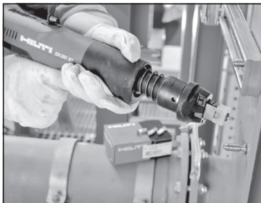
Osadzovanie klinca na oceľovú konštrukciu
