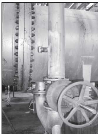
Obr. 5 Nový uzáver vymenený „za prevádzky“
