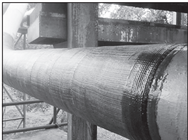
Obr. 4 Oprava potrubia kompozitnou uhlíkovou bandážou
