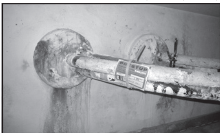
Aj certifikovanou požiarou upchávkou sa do interiéru často dostáva veľmi nežiadúca vlhkosť
