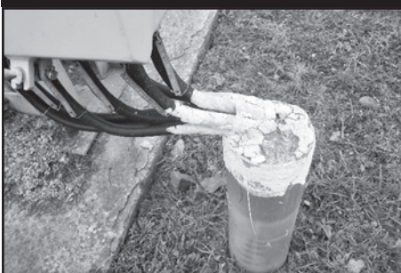
Vlhkosťou narušená protipožiarna upchávka stráca funkčnosť, čím sa zvyšuje riziko šírenia požiaru
