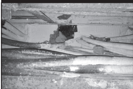
Aj certifikovanou požiarou upchávkou sa do interiéru často dostáva veľmi nežiadúca vlhkosť
