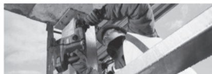
3. Bezpečnosť práce pri vŕtaní a búraní
