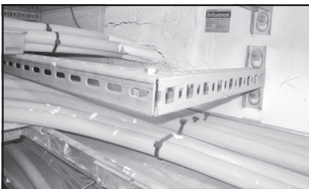
Vlhkosťou narušená protipožiarna upchávka stráca funkčnosť, čím sa zvyšuje riziko šírenia požiaru
