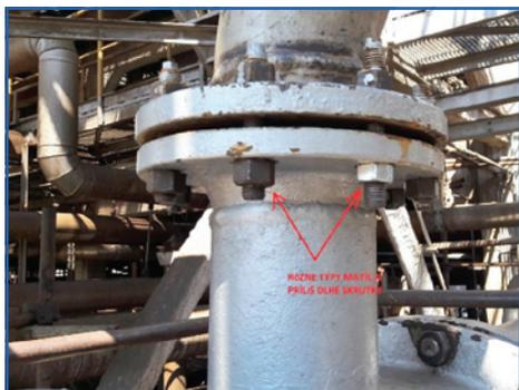
Generálne revízie 2017: V množstve prípadov boli zaznamenané netesnosti prírubových spojov. Dôvodom bola nekvalitná montáž.
