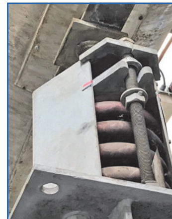
Obr. 6 Značenie polôh pružných závesov pred TZ
