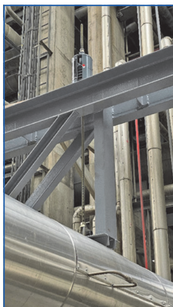
Obrázok 7 Nové riešenie potrubných uložení
