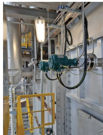
Obr.7: Inštalácia TDLS8000 na jednej z pecí ORLEN Uni-petrol RPA
