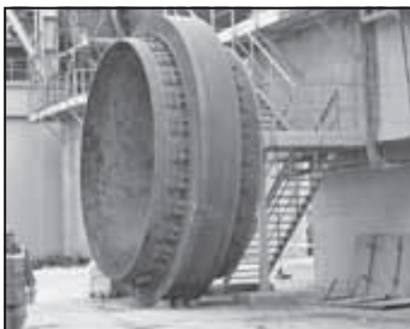
Starý podporný krúžok po vyrezaní z rotačnej pece
