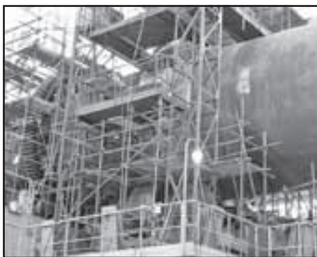
Pracovná plošina s podpornou konštrukciou
