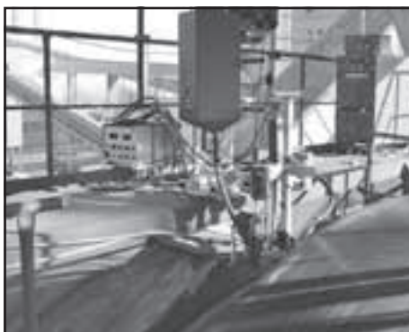
Zváracie pracovisko na pracovnej plošine
