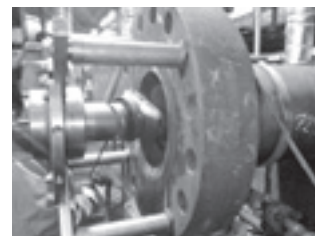
Obr. č. 5 Egalizácia vysokotlaktej príruby
