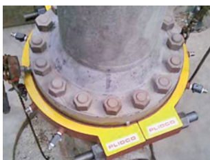
Obr. 7 Prírubový tesniaci prstenec Flange + Repair Ring
