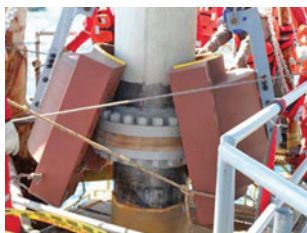
Obr. 10 Inštalácia prírubovej tesniacej objímky na zvislé potrubie
