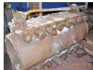
Obr. 11 Delená oceľová objímka po demontáži z potrubia
