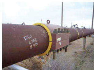
Obr. 2 Zastavenie úniku na rovnom potrubí objímkou Split + Sleeve
