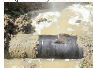
Obr. 4 Bodový únik vody
