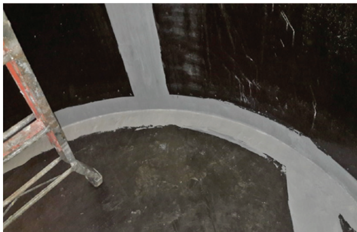
Obr. č. 5 Oprava zvarov PP nádrže
