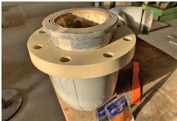
Obr. č. 7 PVC potrubie po oprave
