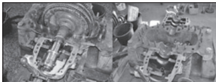
Oprava parní turbíny v Cukrovar, a.s., Vrbátky
