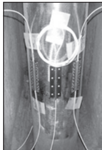
Inštalácia FBG snímačov pred aplikáciou viacvrstvového krytia.
