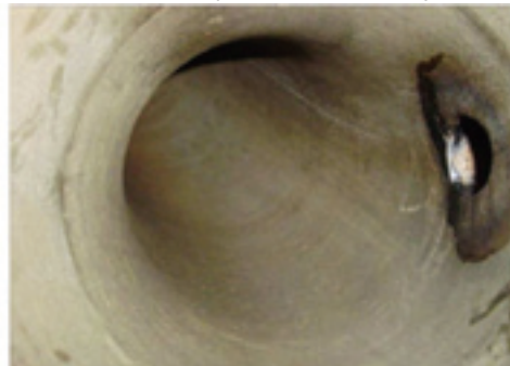
Ukázka odstranění úsad a koroze z potrubí pomocí vodního paprsku.
