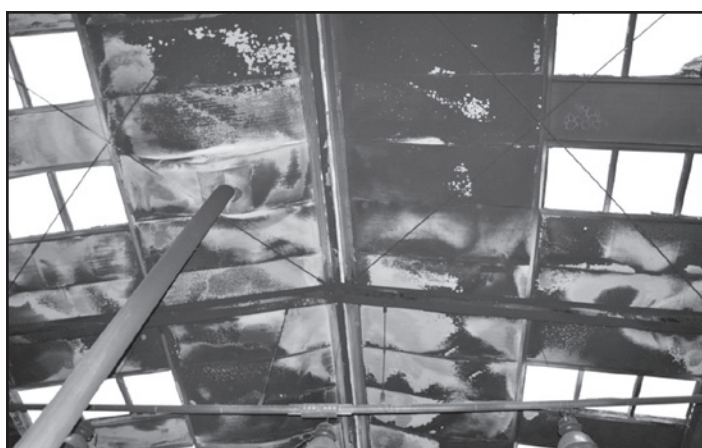
Prehorenie strešného plášťa haly
