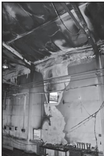
Pohľad na plášť haly z vnútornej strany
