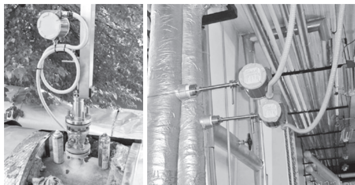
Inštalácie zásuvného vírového prietokomera BHGE MV82 v rámci distribučných parovodov a lokálnych parovodov pre vykurovanie budov. Zdroj: BHGE
