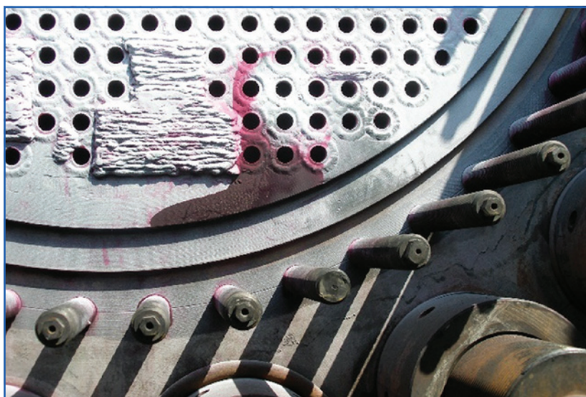
Detail opravenej netesnosti
