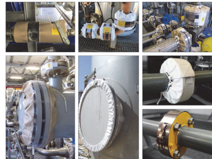
Příklad termoizolační ochrany Power seal Thermo Guard na dveřích kotle
