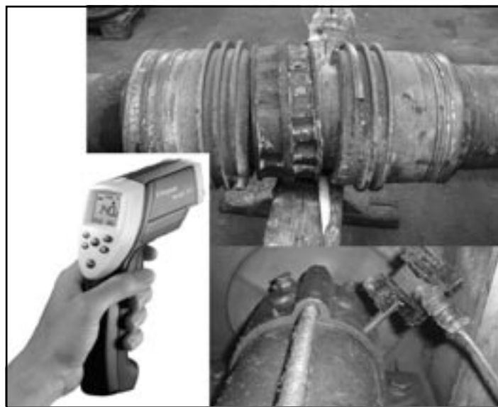
Vysoká teplota, voda a znečistenie maziva je príčinou straty mazania a vážneho poškodenia.
