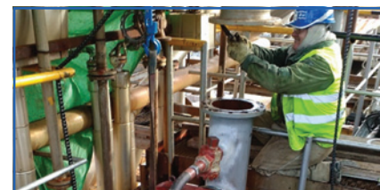
Obr. 7 Výmena uzáveru bez odstavenia prúdenia
