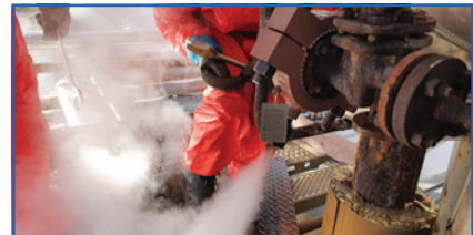
Obr. 5 Oprava úniku prírubového spoja za prevádzky
