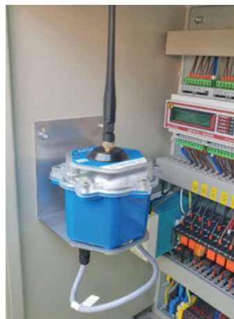
Vľavo: Vzduchový ventil pre odvzdušnenie potrubí. Vpravo: data logger, zber a prenos dát
