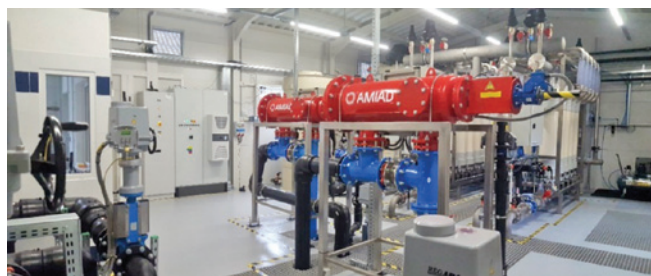
Vľavo: Mobilná filtračná jednotka, solárne napájanie. Vpravo: Úpravňa vody, v popredí automatické samočistiace filtre
