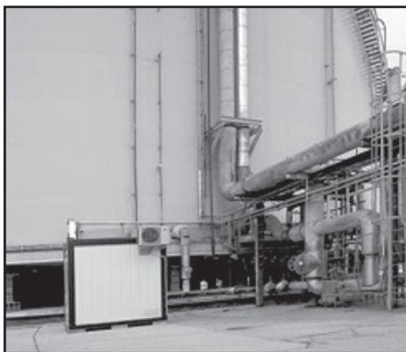
mických a environmentálnych parametrov vypočítava automaticky dve úrovne výstupných parametrov a poskytne podklady pre tretiu – expertnú úroveň. Nasadením ART CES získavame okamžitý prehľad o stave zásobníka. Systém vie identifikovať už minimálny únik čpavku do medzipriestoru.
