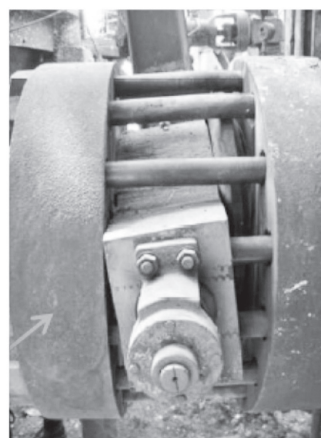
Obr. 2. Klapka po havárii. Podíl na posouzení pevnosti po její rekonstrukci.
