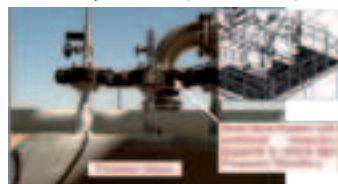
(obr. 2.3: Podopretie malých nátrubkov)
