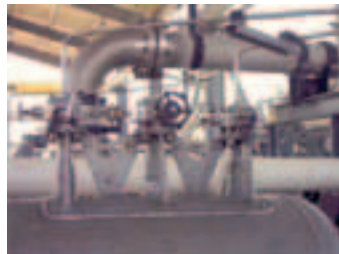
(obr. 5.2 Definitívne podpory nátrubkov – PI a Vent)
