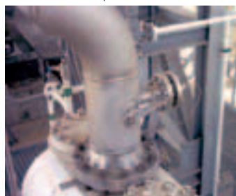
(obr. 5.3 Definitívne podopretie nátrubku – TI)
